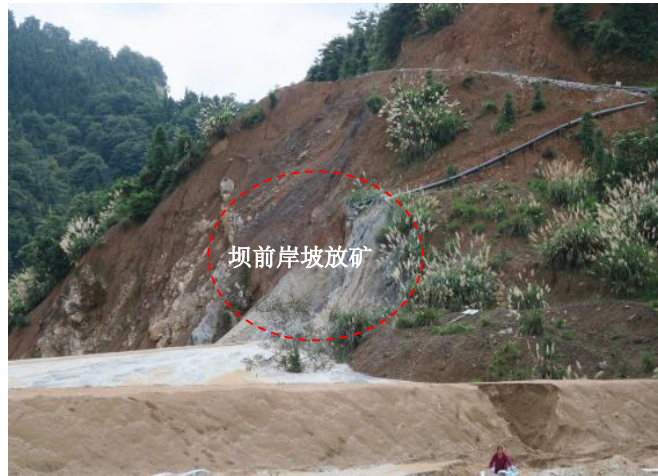
图 2-1 坝前岸坡放矿
