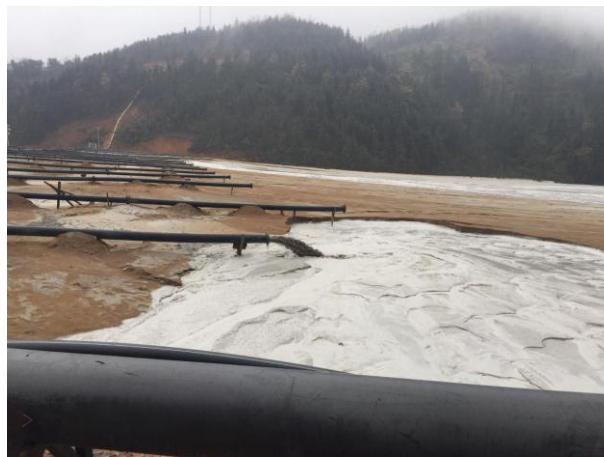
图 2-2 沉积滩面出现侧坡、扇形坡
